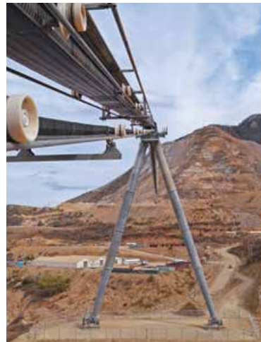
Yükleme istasyonu ve stok boşaltma noktası arasındaki tek direk 44 m yüksekliktedir.
