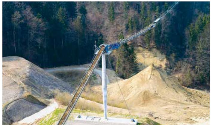
**2016** L'installation RopeCon® exploitée depuis 2005 sur le dépôt de Tüfentobel près de Saint-Gall (CHE) est complétée par une deuxième installation RopeCon® suspendue directement sur la portée de câble. Le transfert des matériaux s'effectue à environ 20 m de haut.
