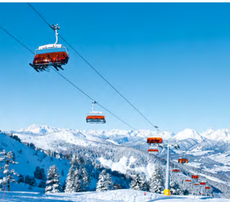
Teleférico com poltronas acopláveis – Haus im Ennstal, AUT
