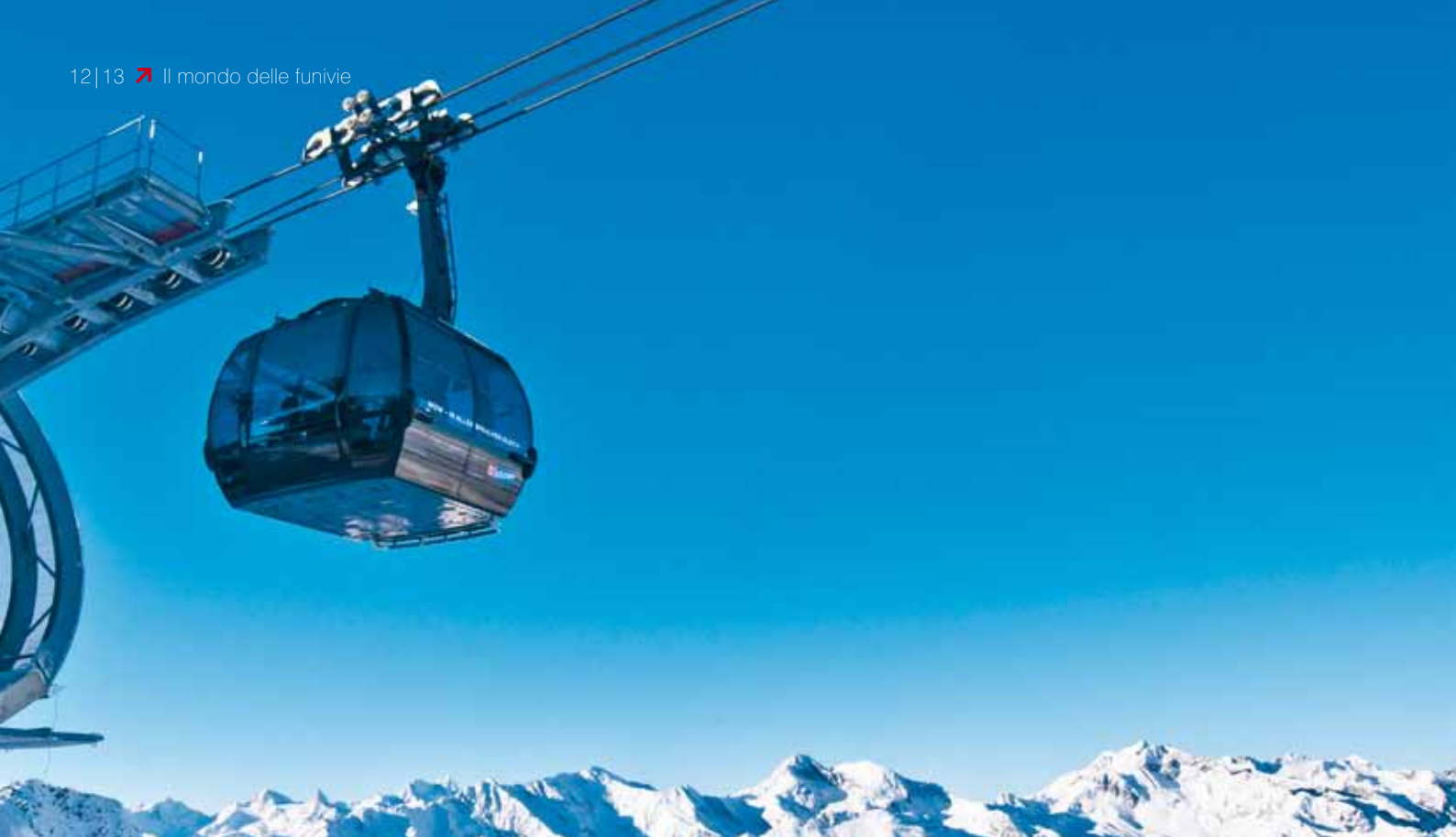
Impianto 3S – Sölden, AUT
