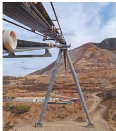
Die einzige Stütze zwischen der Beladestation und der Entladung auf den Schüttkegel ist 44 m hoch.
