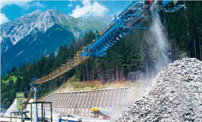
**2001** Das System RopeCon® wird erstmals eingesetzt. Die Anlage bei Strengen, Tirol, transportiert zwischen 2001 und 2004 rund 850.000 m<sup>3</sup> Tunnelausbruchmaterial über eine Schnellstraße, eine Eisenbahnlinie und einen Fluss.
