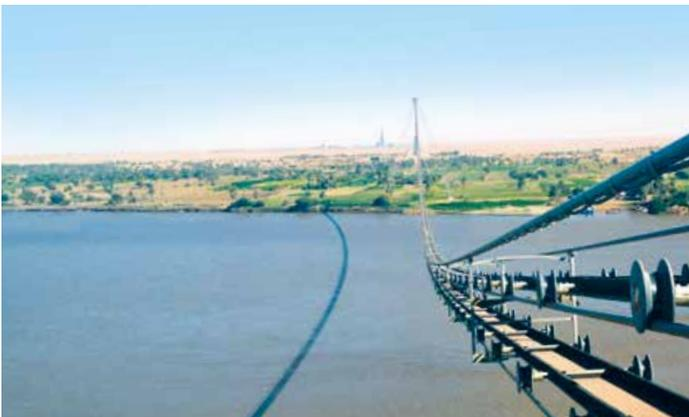
**2011** Eine RopeCon® Anlage überspannt den längsten Fluss der Erde, den Nil, der an dieser Stelle rund 850 m breit ist.
