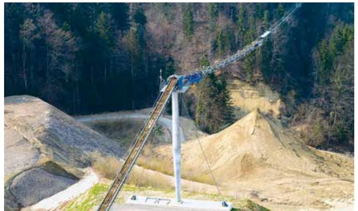
**2016** L'impianto RopeCon® operato dal 2005 sul deposito Tüfentobel di San Gallo (SVI) viene ampliato con un secondo impianto RopeCon® direttamente collegato alla campata precedente. Il trasferimento del materiale avviene a circa 20 m di altezza.
