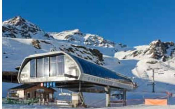
Die 6-CLD Rosaël, Frankreich, ersetzt eine 4-CLD Baujahr 1985. Die Bahn ist für den Betrieb bei Windgeschwindigkeiten von bis zu 30 m/s (108 km/h) ausgelegt. S 3
