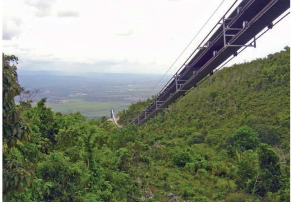
Das Materialtransportsystem RopeCon verbindet die Vorteile bewährter Seilbahntechnologie mit jenen herkömmlicher Förderbänder
