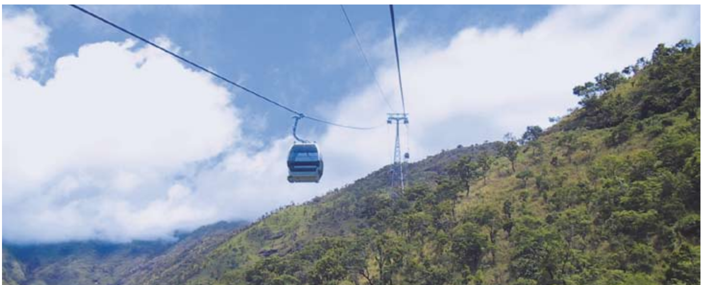
Die Obudu-Gondelbahn zum Protea Hotel Ranch Resort auf dem Oshie-Ridge-Plateau. Die Anlage ist fix abgespannt. Bei zwei der drei Stützen befindet sich eine Bergwinde. Die Bahn wurde gemäß OITAF-Richtlinien gebaut und abgenommen.
