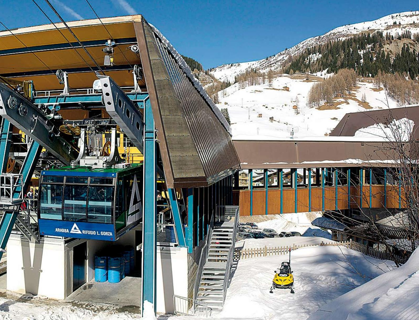
Die neue Funifor hat zwei Kabinen für 80 Passagiere und zwei Fachwerkstützen mit 42 m bzw. 18 m Höhe. Das System ist sehr wind- und spurstabil und benötigt keine speziellen Einfahrtsvorrichtungen.
