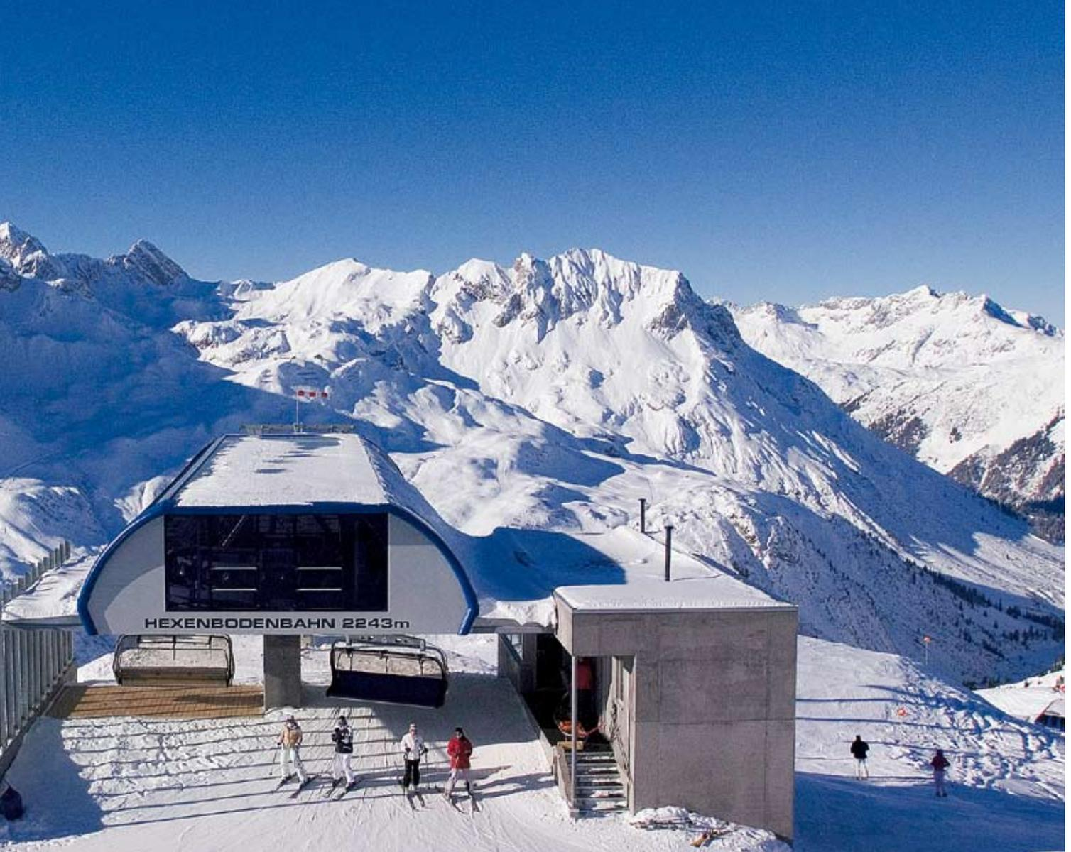
Die Bergstation ist eine klassische UNI-G-Station. Zusätzlich sind die Skifahrer beim Aussteigen durch eine Windschutzwand aus Glas geschützt. Auf der Stirnseite wurde ein Podest für die Seilkontrolle angebracht; das Stationsdach ist für Servicearbeiten begehbar. Für den Bau wurde eine Materialeisbahn eingerichtet bzw. ein Helikopter eingesetzt..
