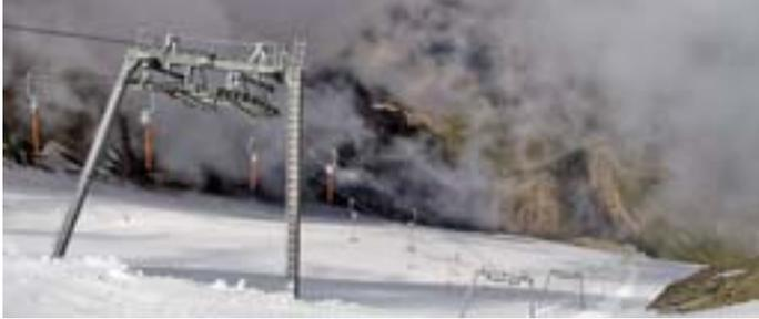
Gletscherstütze: Stützenfüße und Rollenbatterien sind seitlich verschiebbar und gelenkig gelagert. Sie können in alle Richtungen geneigt werden.
