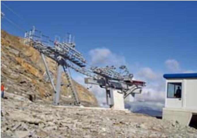
Talstation Kaserer 1 unterhalb des Hintertuxer Gletschers in 2705 m Höhe: vorne der Steher für die Halteseilabspannung, dahinter der Antrieb mit dem 230 kW Gleichstrommotor und dem hydraulisch klappbaren Klemmenversetzpodest.
