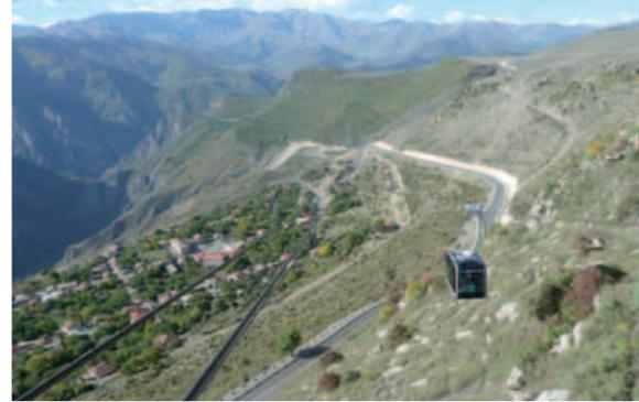
In Armenien baute Garaventa die längste Pendelbahn der Welt: Streckenlänge 5,7 km, vier Spannfelder (das längste misst 2,7 km) größter Bodenabstand 400 m. S 15
