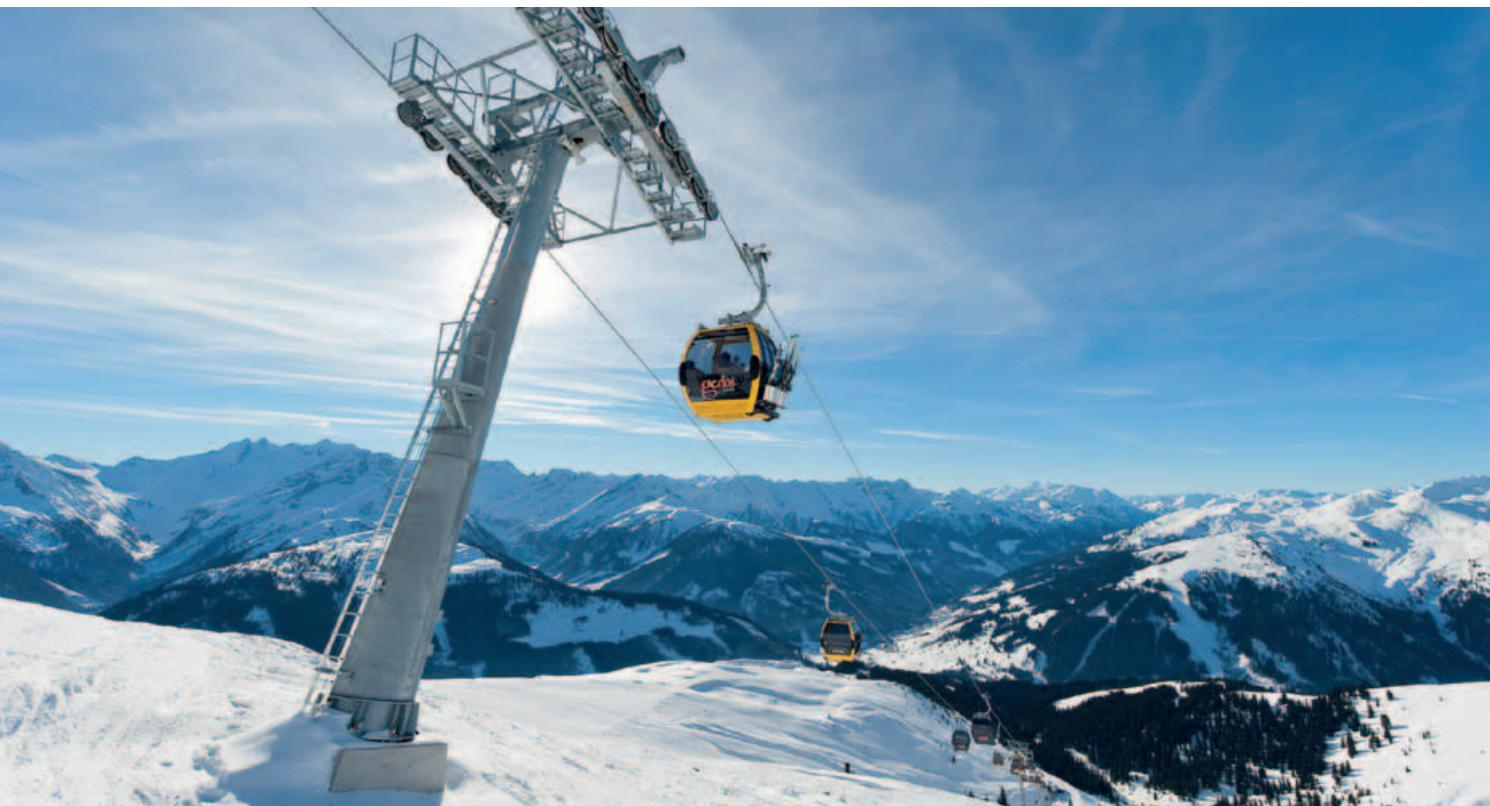
Die neue 8-MGD Falschbachbahn ersetzt einen 4er-Sessellift Baujahr 1994. Die Stationsstandorte und die Trassenführung wurden beibehalten. Der vollautomatische Stichgleisbahnhof ist seitlich der Talstation in den Berg integriert. Da von Königsleiten aus gleichzeitig ebenfalls eine neue 8er-Gondelbahn installiert wurde, haben die Skigebiete Gerlos und Königsleiten deutlich an Attraktivität gewonnen.
