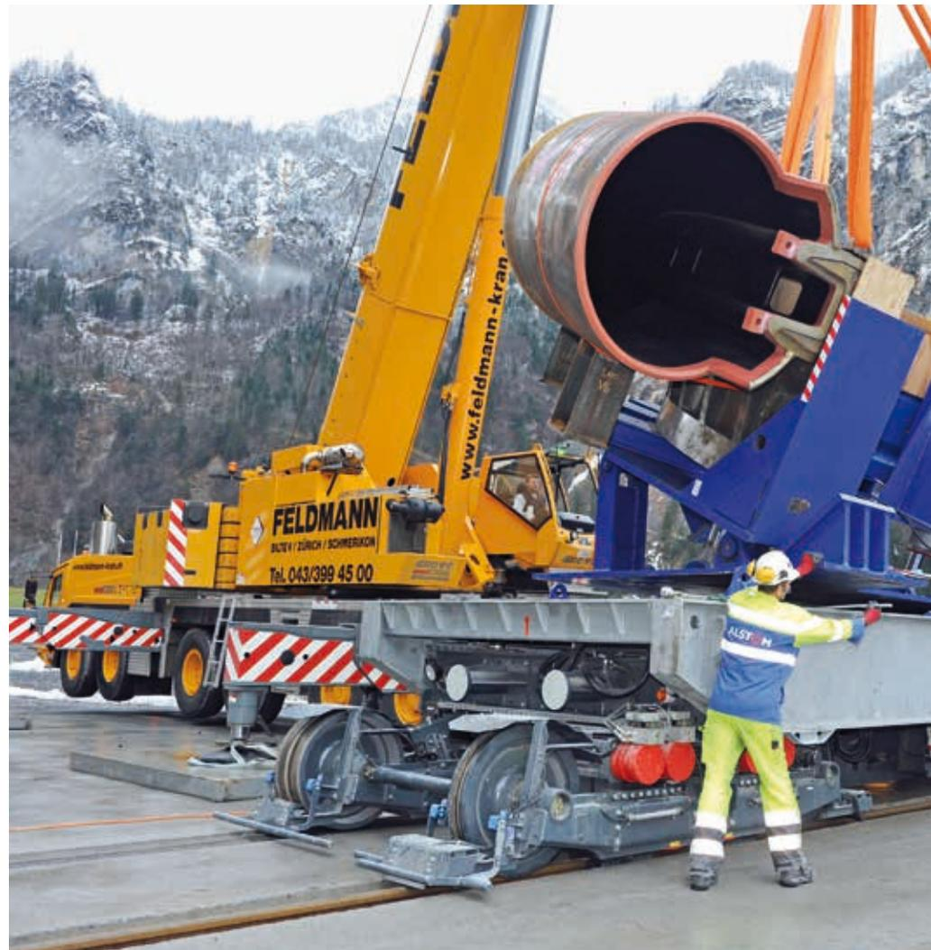
Beladung eines 80t schweren Stützschaufelring-Teiles für die Turbine in der Talstation und Transport durch die Kaverne zur Bergstation.
