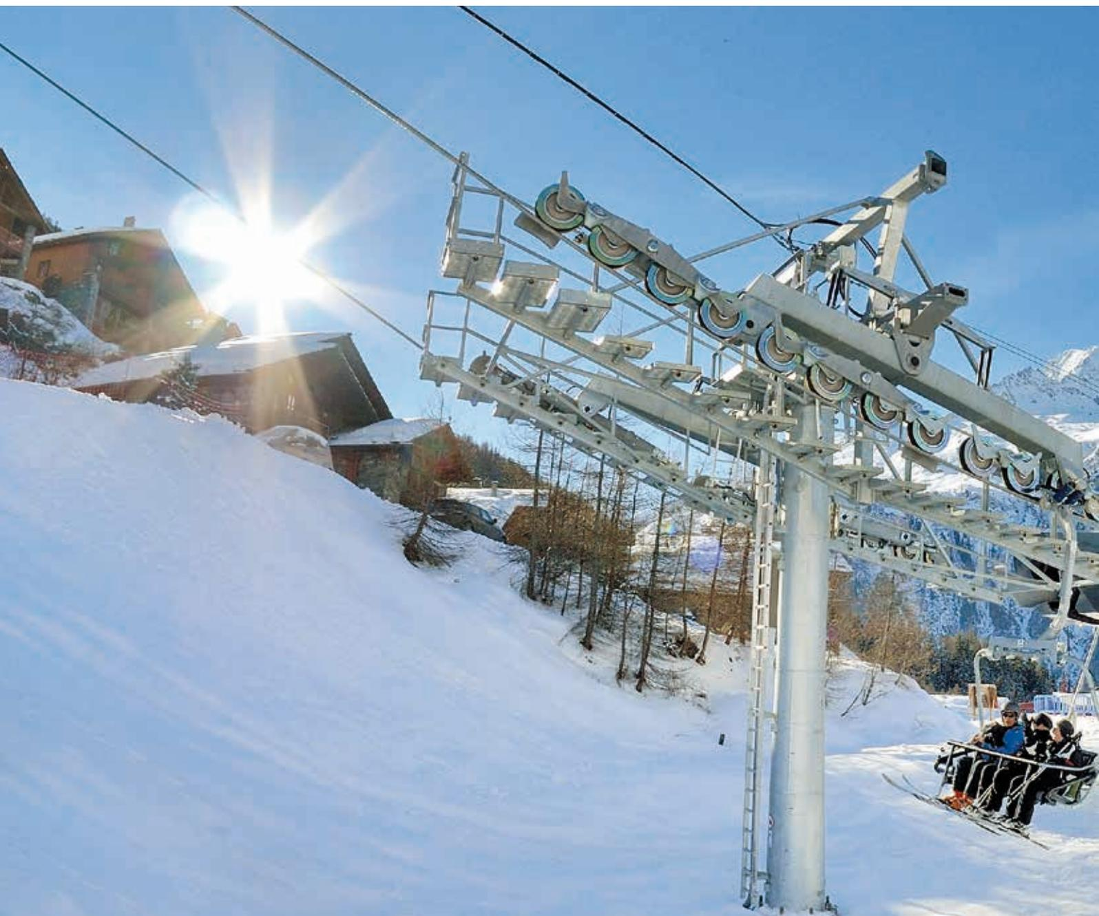
ger ein- oder aussteigen wollen, wird die Einstiegsgeschwindigkeit automatisch um die Hälfte verringert. Die Kapazität der Talförderung ist der Nachfrage angepasst: mit 1.000 P/h ist sie nur halb so groß wie bei Bergfahrten.
